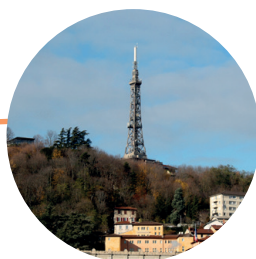
Tour métallique de Fourvière 1894
